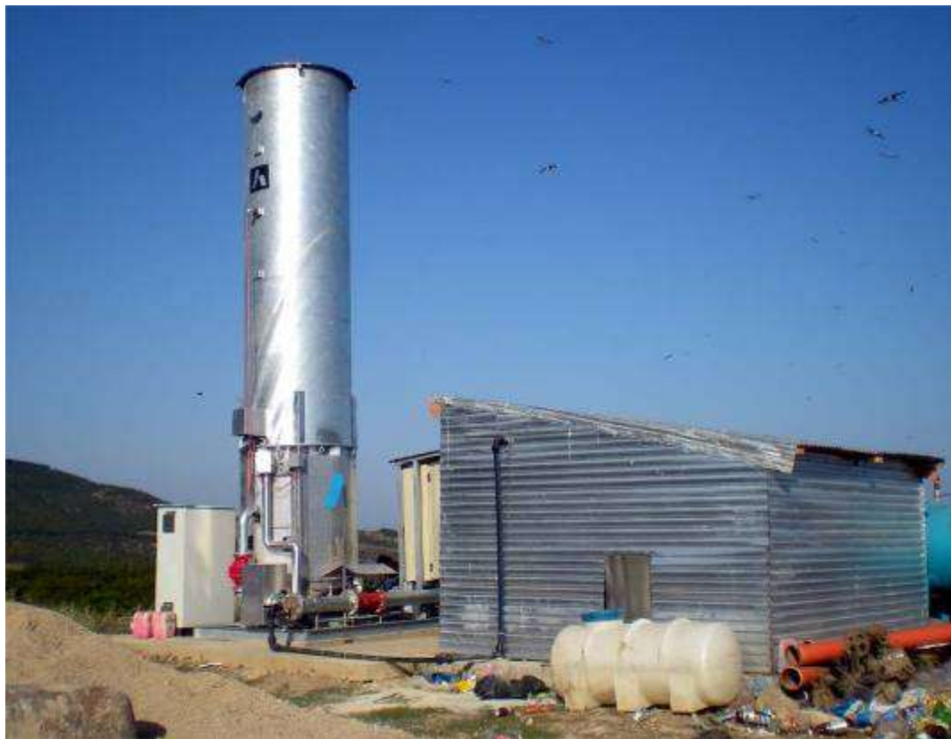
Сжигание биогаза в факеле, август 2008 700(500) м 3 /час биогаза (Гафса/С6 Capital/СММ/НТЦ Биомасса)
