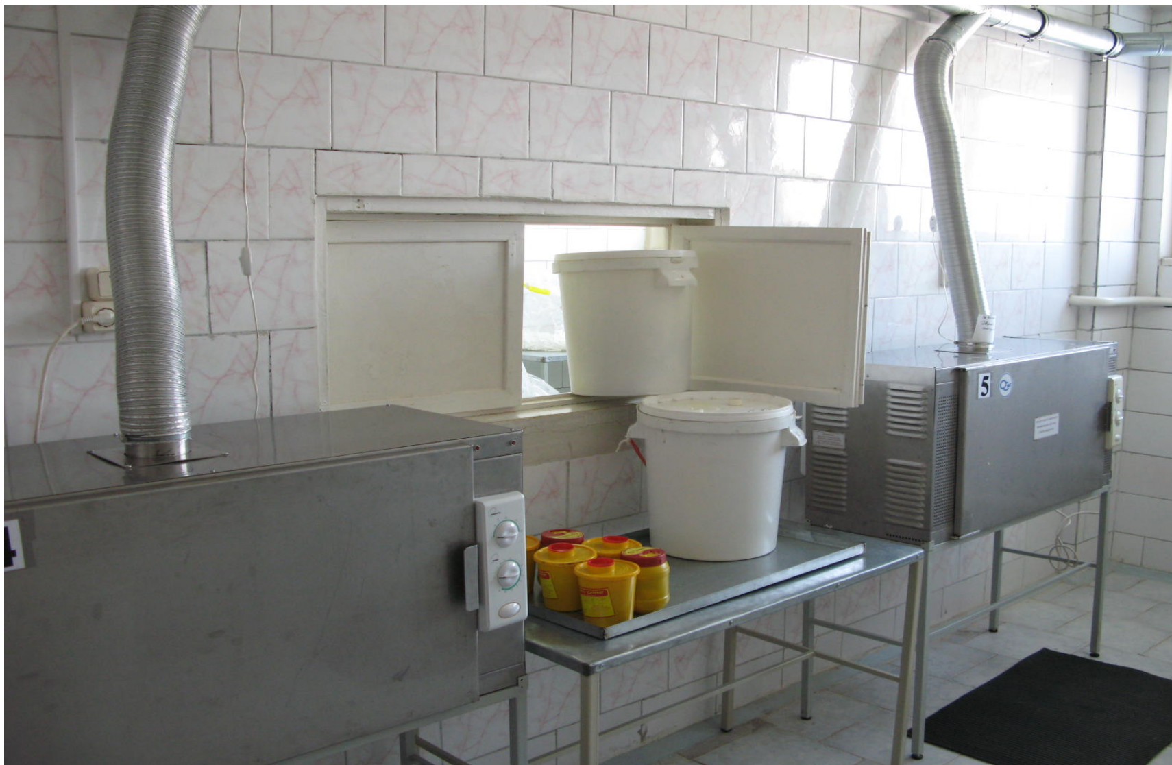
Помещение для обеззараживания отходов
